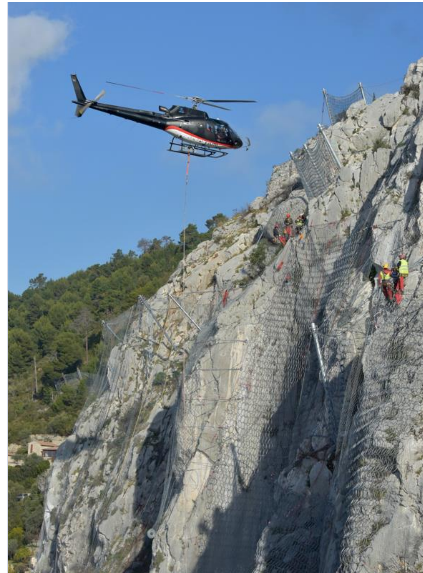
Travaux De Protection Contre les chutes de blocs (Menton La Giraude - 06)
